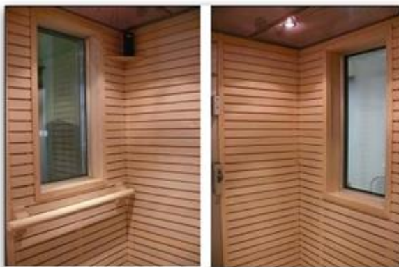
WNETRZE KOMORY- DREWNIANE PANELE
